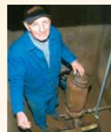
Geräusch: die permanenten Druckstöße beim Verschließen des Stoßventils erinnern an die Rammstöße eines Widders.
